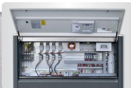
Установка компрессоров со встроенным инвертором позволяет значительно снизить пусковые токи чиллера.
